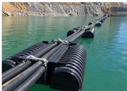
Flotación de cables eléctricos.
