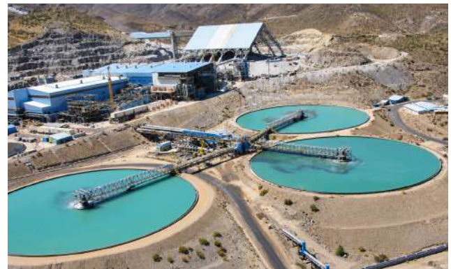
Sistemas de captación.
