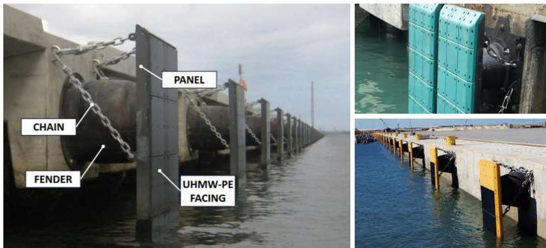
Las defensas de muelle son críticas para la absorción de energía que los buques generan durante el atraque en la estructura de un puerto.
